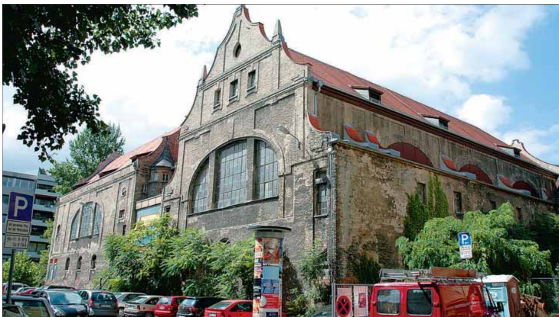
Ein Dreiviertel-Jahrhundert wurde hier gebadet. Seit 26 Jahren ist es damit vorbei. Was wird aus dem Jugendstilgebäude in der Mitte von Bergheim? Foto: Hentschel
